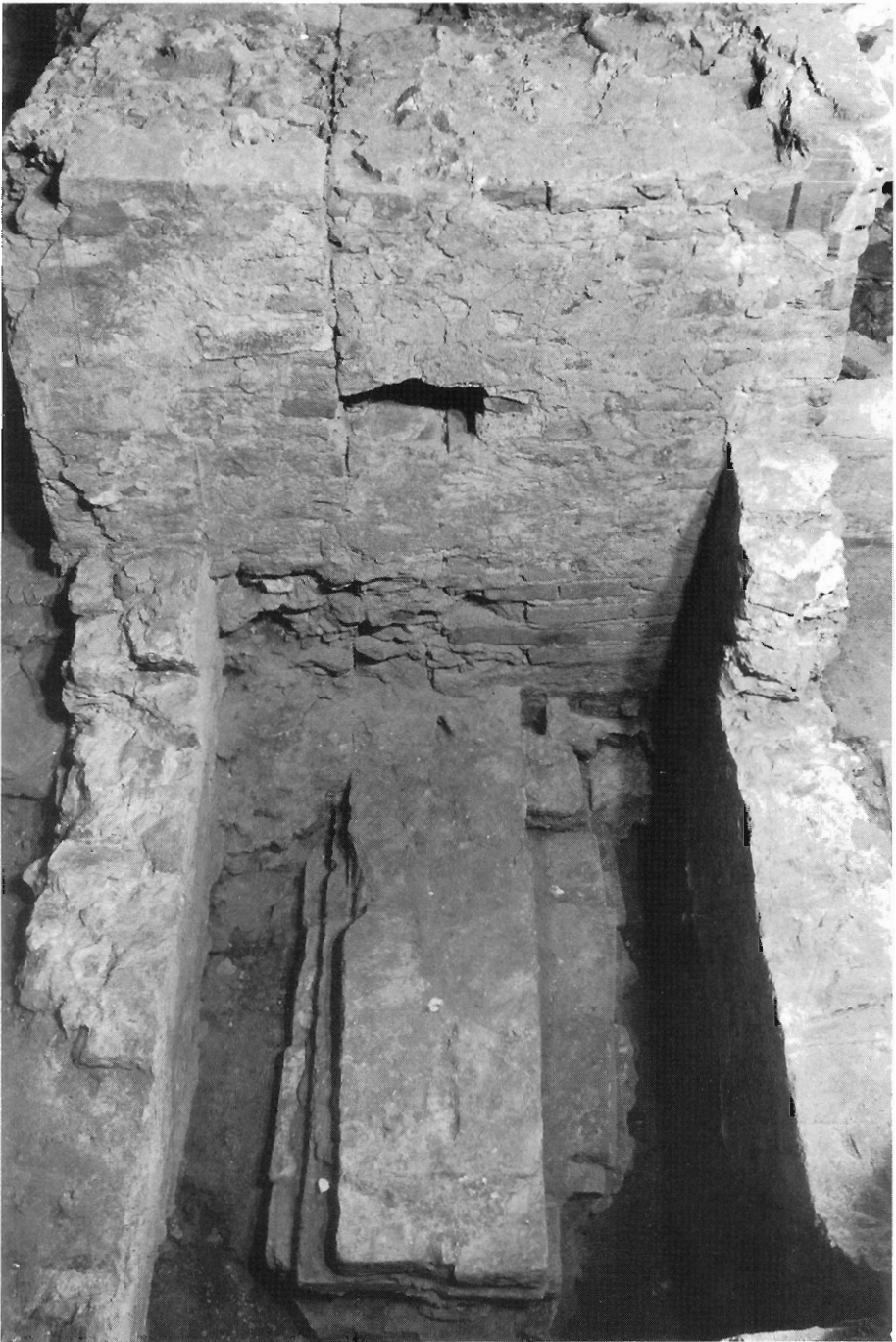
Fig. 4 – Pilastro originario e divisione muraria successivamente abbattuta con resti di alloggiamento di cardine per probabile cancellata.
