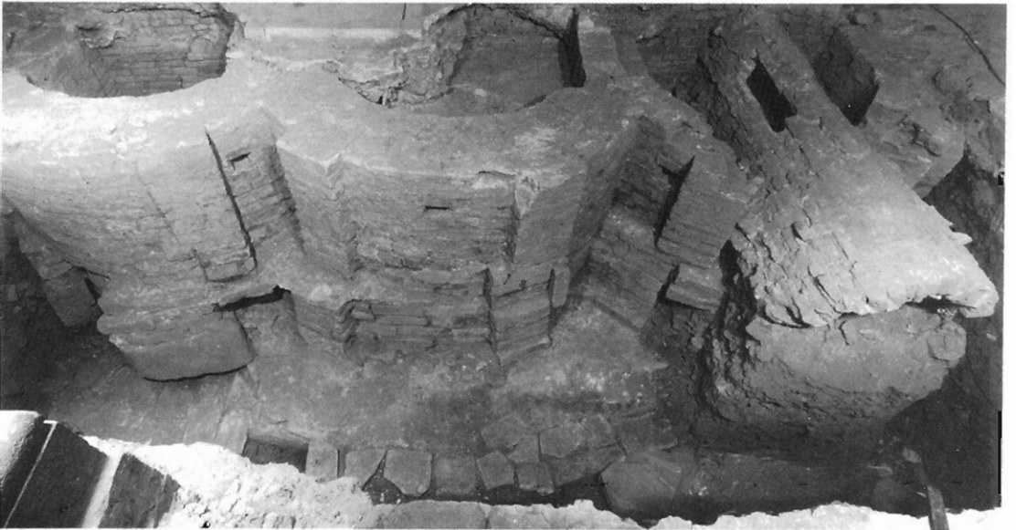
Fig. 3 – Chiesa di S. Paolo. Retro delle absidiole della chiesa primitiva con l'evidenza di due fasi costruttive e variazioni nell'imposta delle lesene.
